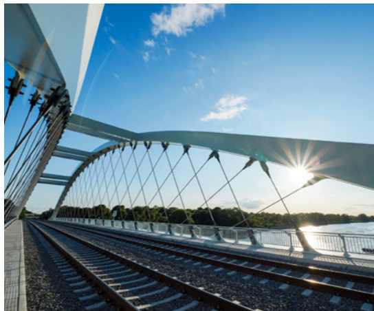
Die Oderbrücke mit ihrem Netzwerkbogen mit 130 Metern Spannweite und 88 Carbon-Hängern. Bild links: Volker Emersleben / Deutsche Bahn AG
